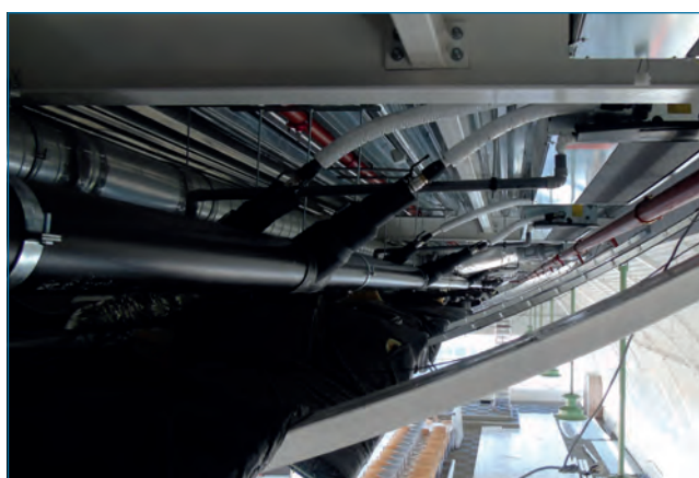
iFIT in combinatie met COOL-FIT 2.0 in kas Bleiswijk
