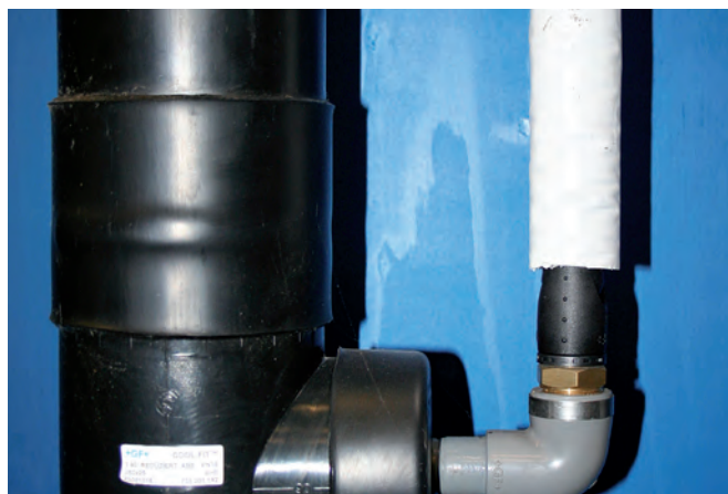
aftakking iFIT op COOL-FIT
